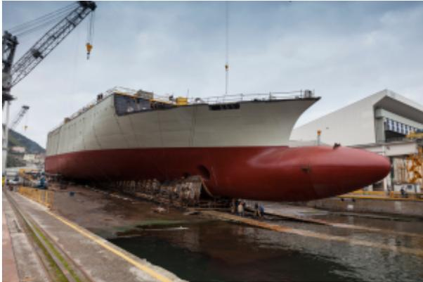
Il troncone, che costituirà la parte di prua di "Silver Muse", è lungo 111 metri, largo 27 metri, alto 14 metri e ha un peso di circa 2400 tonnellate. Il varo tecnico è avvenuto su scalo e nei prossimi giorni il troncone sarà trasportato via mare nello stabilimento di Genova Sestri Ponente, dove, dopo il taglio della prima lamiera avvenuto lo scorso luglio, proseguirà la costruzione della nave, la cui consegna è prevista nella primavera del 2017.
